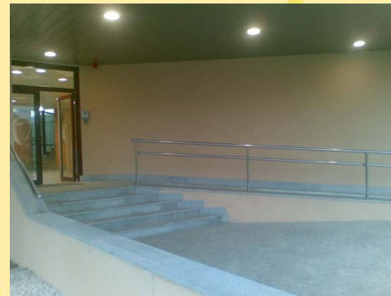
Rampa de acceso exterior al Puesto de Mando
